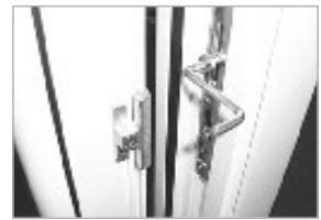
В зависимости от производителя, их внешний вид может различаться, но принцип работы у всех один и тот же. При помощи вращения эксцентриков шестигранником или плоскогубцами можно добиться той степени прижима створки к раме, которая необходима.
